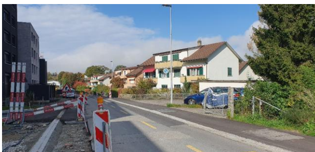
Abb. 1: Blick von Osten auf die zu ersetzenden Häuser rechts
